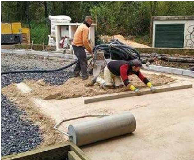
Suelo drenante instaurado en la zona exterior.
