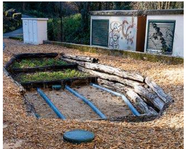
Aspecto general del estanque artificial ejecutado.
