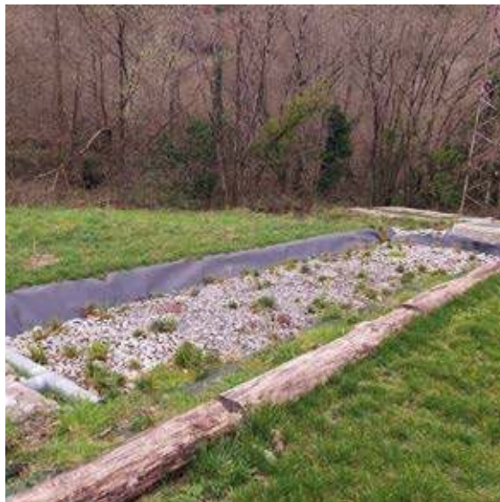
Sistema de fitodepuración y arqueta de separación de grasas.
