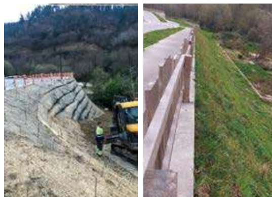
Estabilización de talud con bioingeniería durante la obra (superior e inferior izquierda) y después de medio año (inferior derecha).
