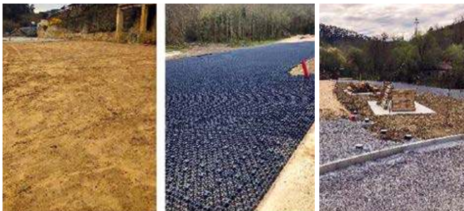
Instalación de las celdas de polipropileno.
