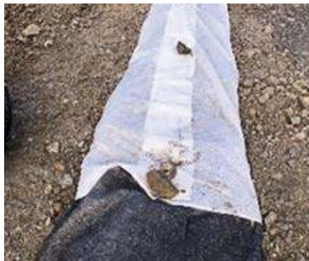
Proceso de construcción de la zanja verde.
