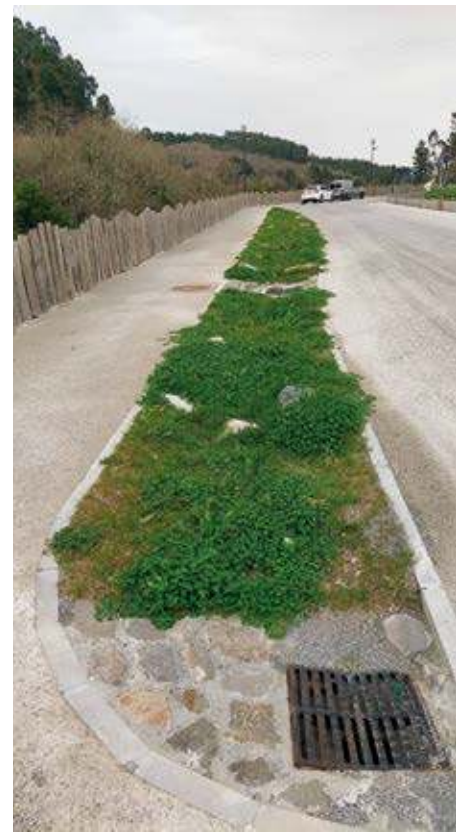
Zanja verde medio año después de finalizar la obra.
