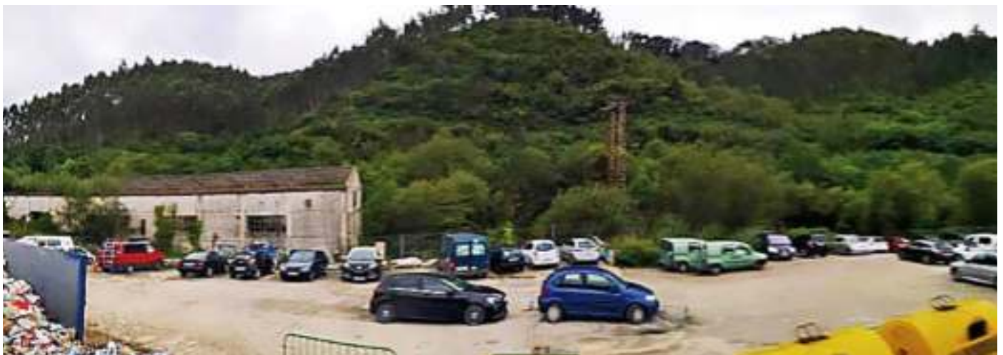
Estado de la zona antes de la intervención.
