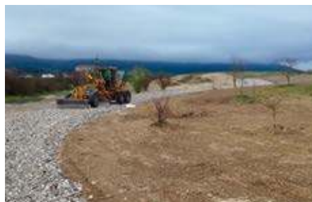
Trabajos para la ejecución de caminos con material reciclado.
