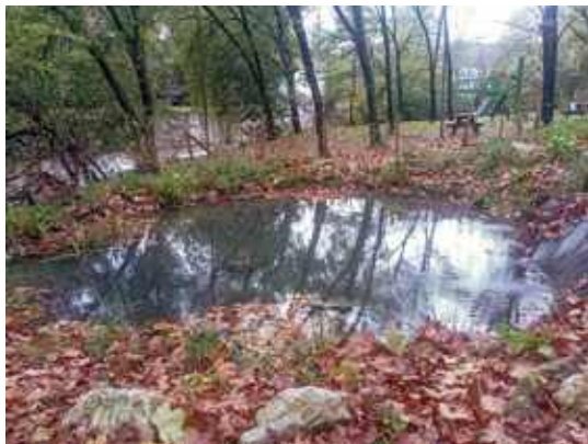
Fitoarazte-putzu konektatuak (goian, legarren eta helofiten iragazki-putzua, eta, behean, hezegune-putzua).
