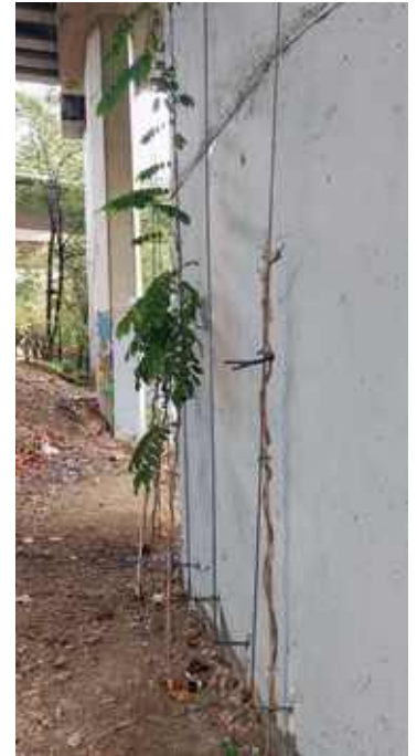
Zutabean ainguratutako kableak, tarte bat dutela.
