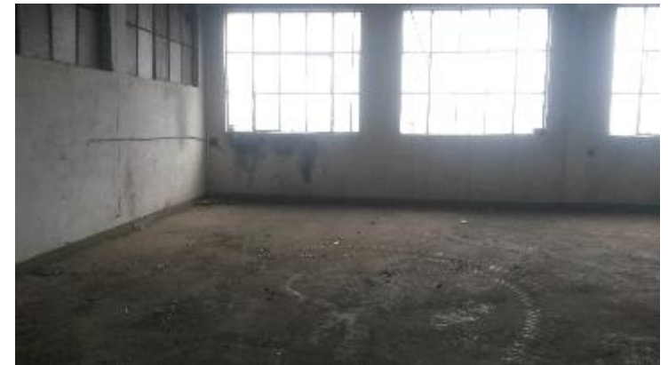
Limpeza previa. Fuente: LEZAMA Demoliciones
