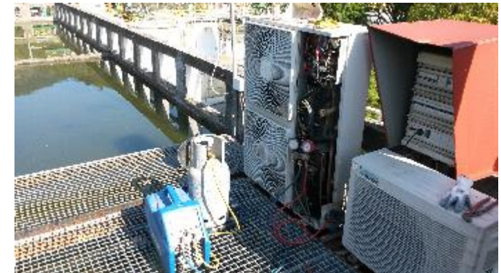
Vaciado de aceites y grasas. Fuente: Lezama demoliciones.
