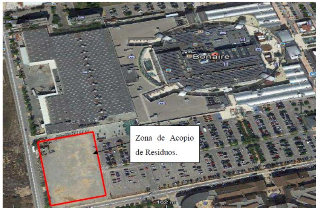
Obra CC Bonaire-Valencia. Fuente: Lezama Demoliciones
