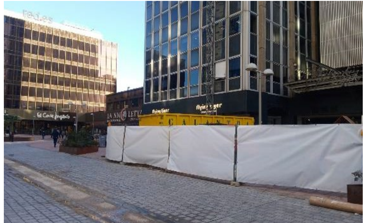
Obra MADRID. Zona de descenso de material y acopio. Fuente: LEZAMA Demoliciones.
