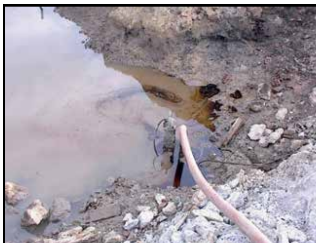
Foto N°10.5: Bombeo con bombas de achique en zonas excavadas
