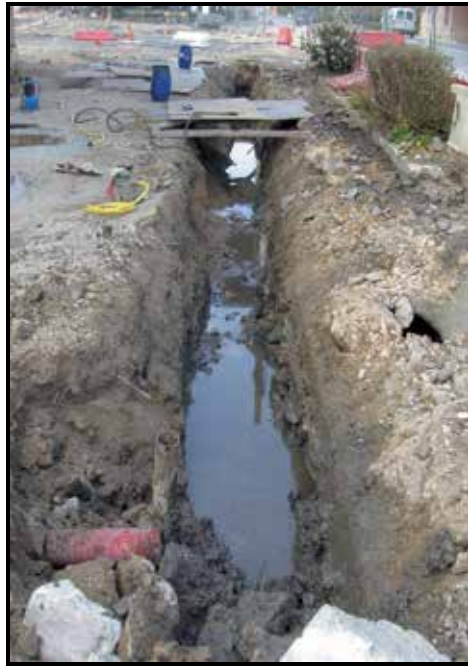
Foto N°10.6: Bombeo desde zanjas perimetrales
