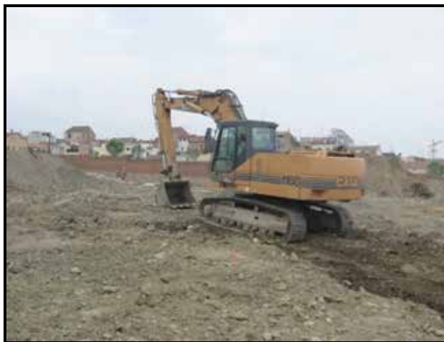
Foto N°10.3: Retroexcavadora de orugas
