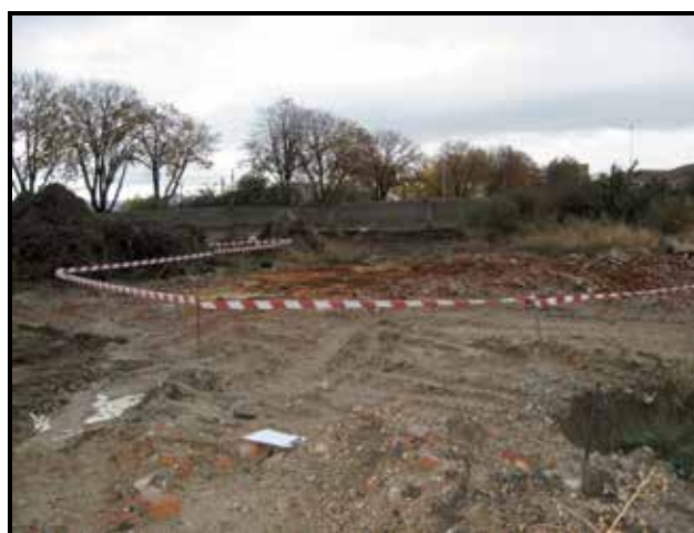
Foto N°10.1: Balizado de zonas de excavación
