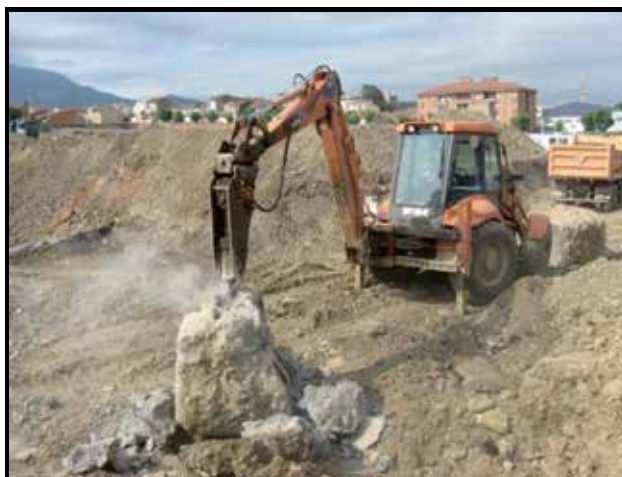
Foto N°10.4: Martillo neumático de retroexcavadora
