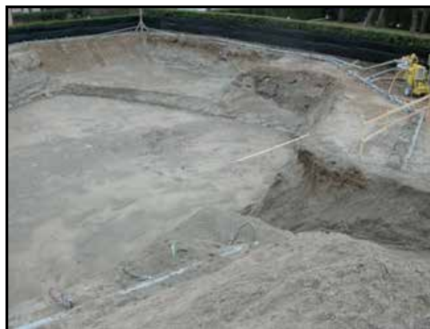
Foto N°10.7: Bombeo mediante sondeos de pequeño diámetro
