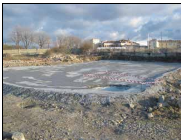
Foto N°10.10 Preparación de zona de almacenamiento temporal hormigonada con depósitos subterráneos para almacenar lixiviados
