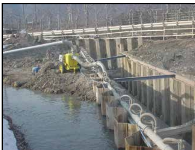
Foto N°10.8: Instalación de barreras impermeables
