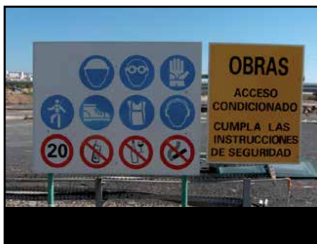
Foto Nº15.1: Señalización de riesgos y medidas de seguridad
