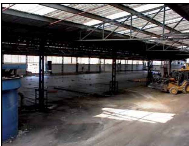
Foto N°10.12: Zona de almacenamiento cubierto
