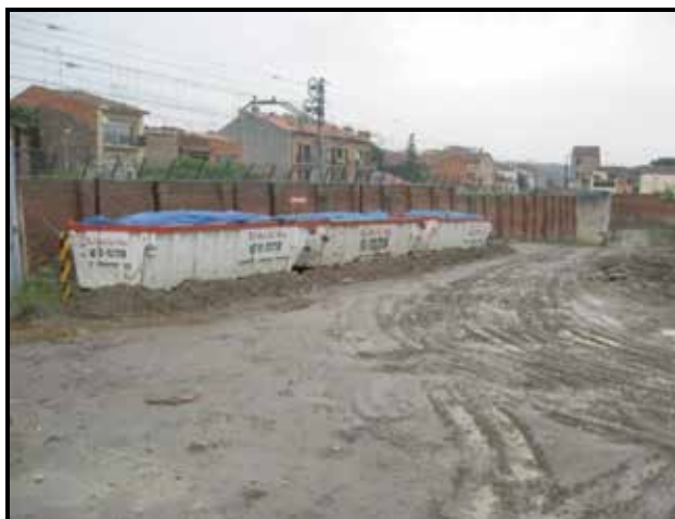
Foto N°10.9: Acopio de suelos excavados en contenedores
