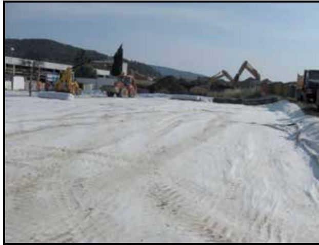
Foto N°10.11: Instalación de geomembrana en zona de almacenamiento temporal
