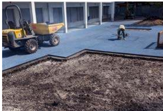
Estado inicial del patio y obras de despavimentación.
