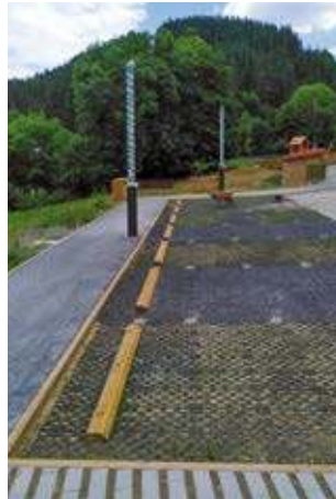
Celdas de polipropileno reciclado rellenas de gravas de diferentes tonalidades para las plazas de aparcamiento.
