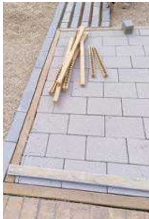
Baldosas de hormigón poroso continuo para aceras.
