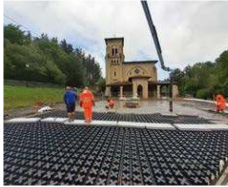
Puesta en obra de las losas de hormigón perforadas para los viales de tráfico rodado.
