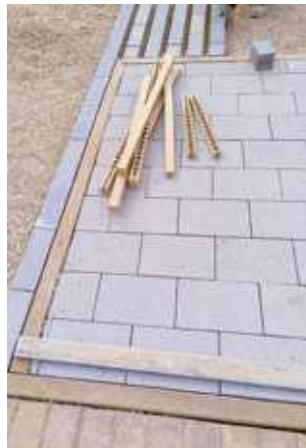
Hormigoi porotsu jarraituko baldosak espaloiak egiteko.
