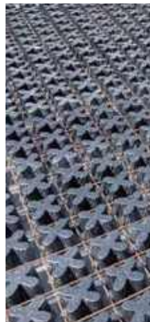
Ibilgailu gurpildunen trafiko-bideetarako hormigoizko lauza zulatuetan obran jartzea.
