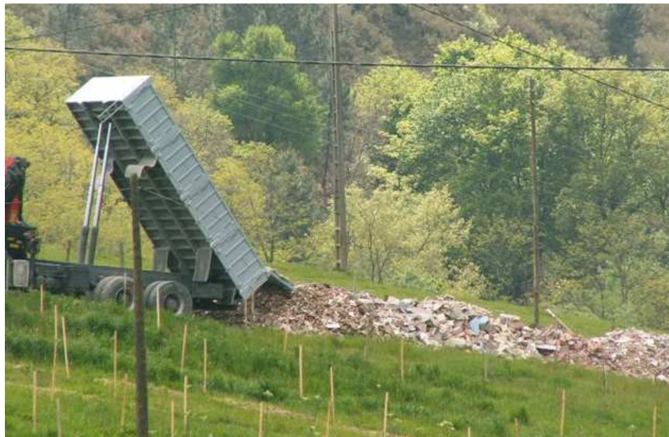
Imagen 1. Vertido ilegal de RCD.
